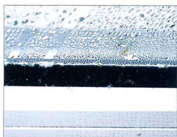
I distanziatori tradizionali in alluminio pongono un elevato rischio di formazione di condensa e muffe
